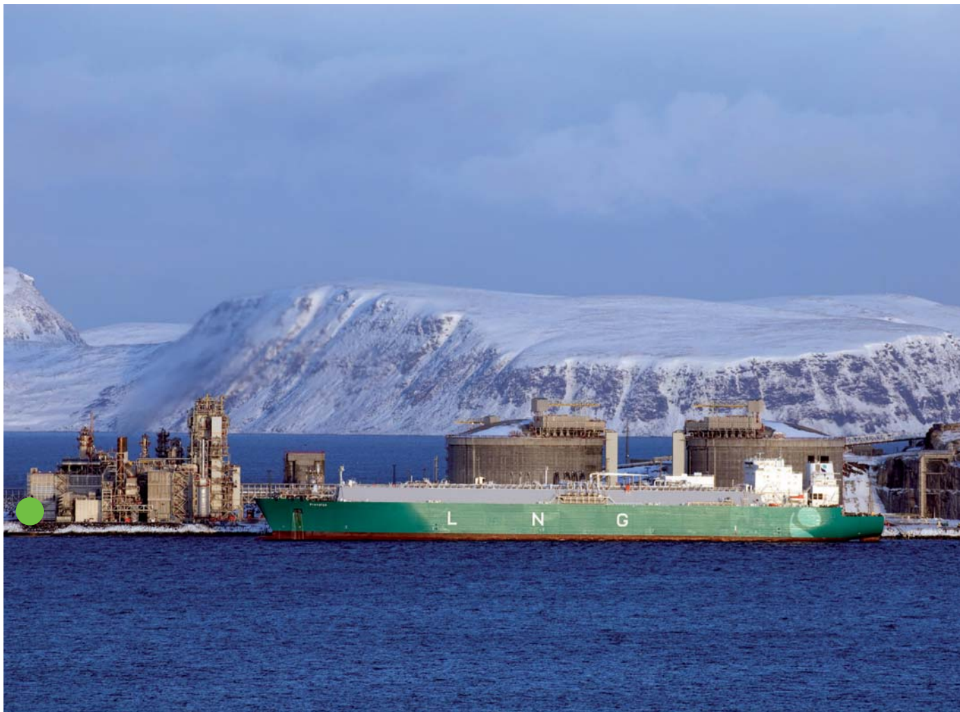
Grupul are în portofoliu 15 metaniere, iar alte cinci sunt în construcție
