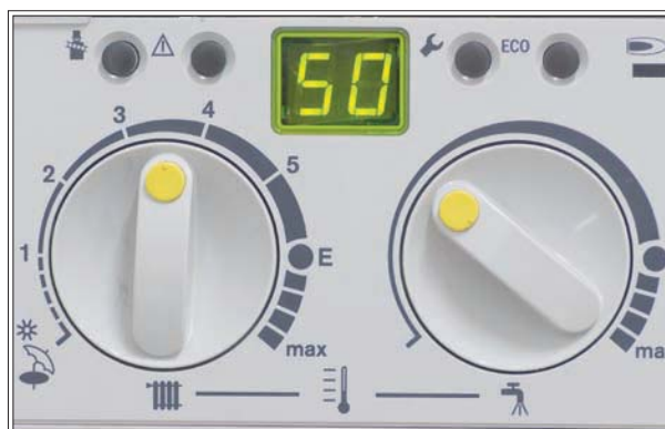
Pentru că temperatura gazelor evacuate este de doar 45-50° C (față de 120° C la o centrală clasică), centrala cu condensare economisește energie
