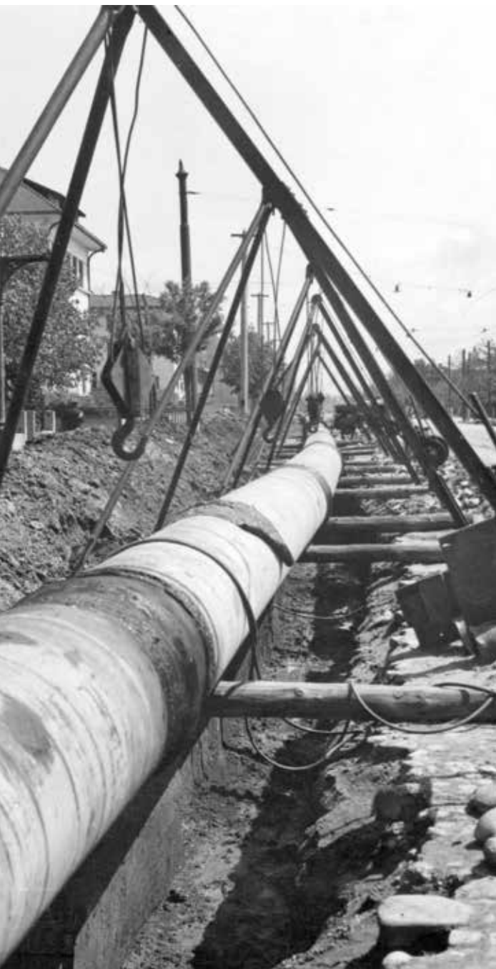
Montarea conductelor de gaze naturale cu ajutorul macaralelor, Șoseaua Panduri, București, 7 mai 1943
